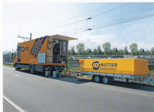
Maschinen- und Supportfahrzeug für UV-Liner-Einbau.
