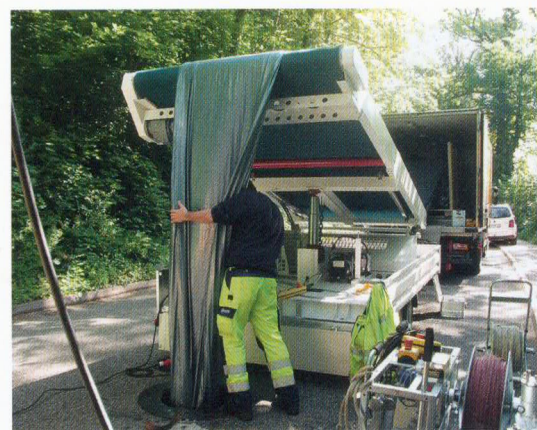
Mit einem Förderband wird der 260 Meter lange und 6,4 Tonnen schwere Liner an einem Stück eingezogen.
