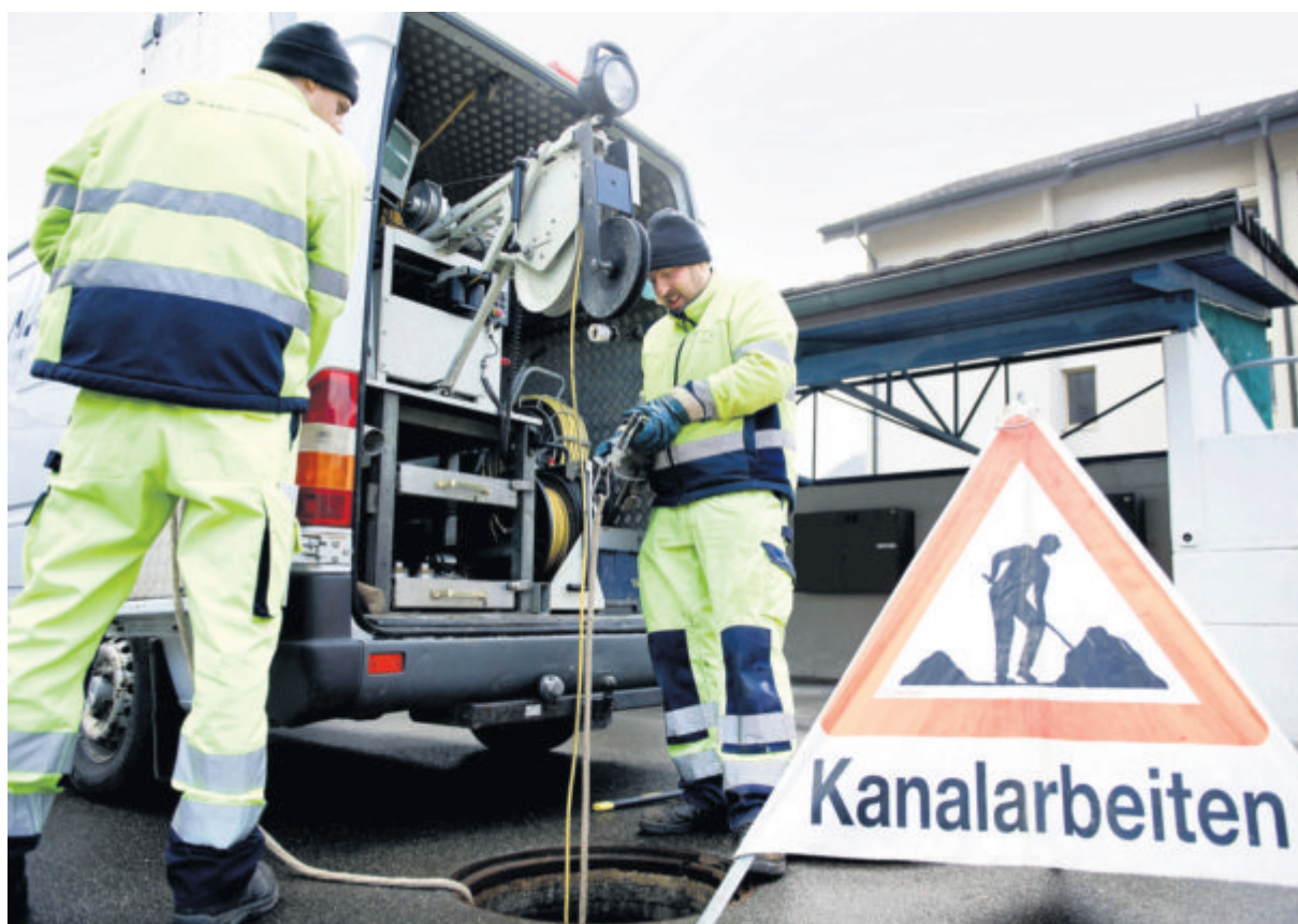
Michael Odermatt (links) und Peter Zumbühl von ISS Kanal Services bei Arbeiten im Stanser Quartier Steinersmatt.
