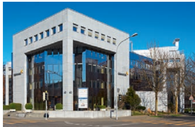
Das Bürogebäude Baslerpark zeichnet sich durch ein innovatives Dienstleistungskonzept aus.
