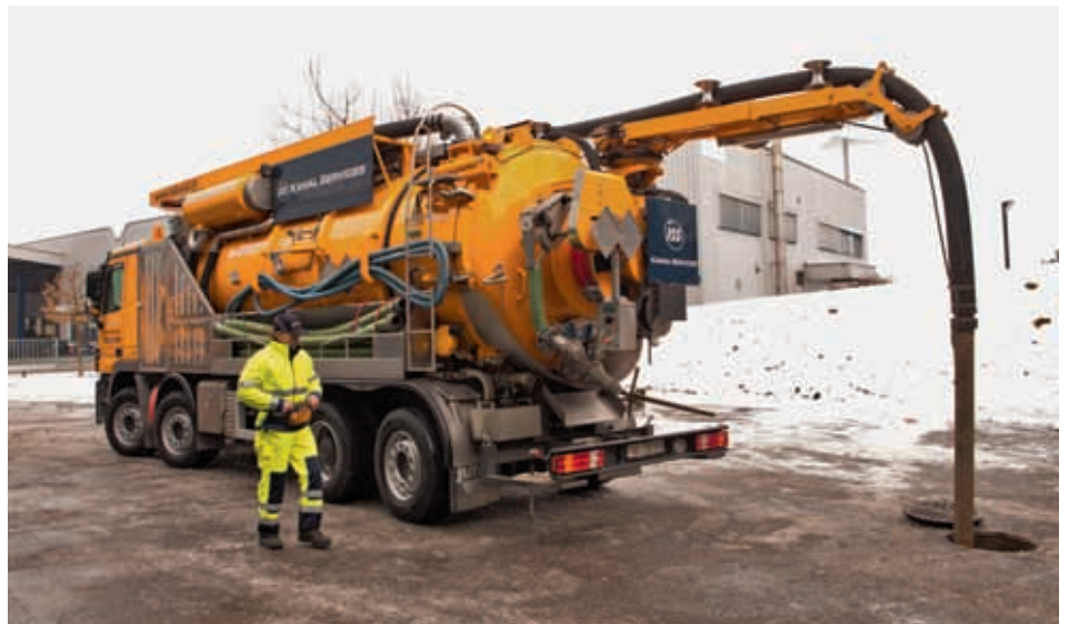
Maschinist Andy Keusch von der ISS Kanal Services AG entleert einen Strassenschacht mit der mobilen Aufbereitungsanlage. Bilder: ISS Kanal Services AG
