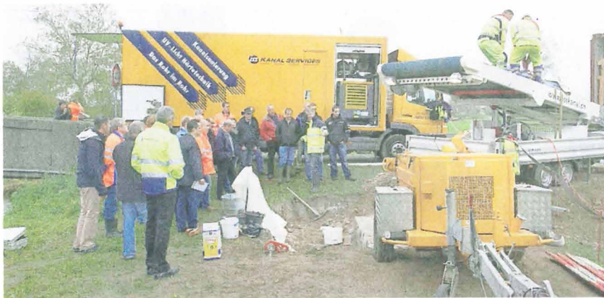
Behördenvertreter verfolgen die aufwändigen Sanierungsarbeiten. ZVG
