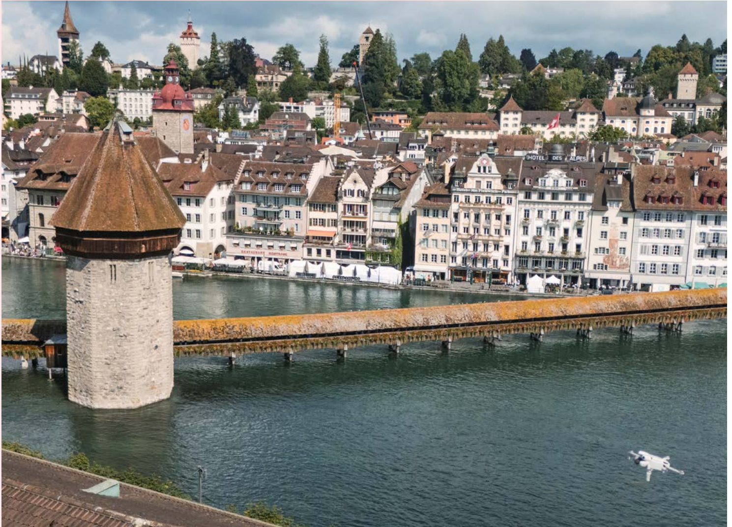
Contrôle des bâtiments à l'aide d'un drone à haute altitude
