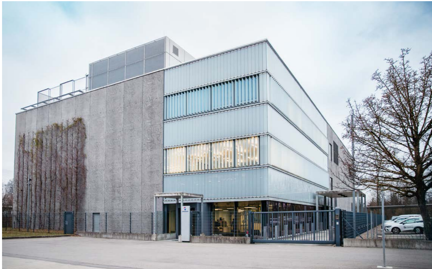
Le centre de données de Wankdorf pose de nouveaux jalons en matière de performance, de sécurité, de disponibilité et d'efficacité énergétique. Grâce à un nouveau concept de positionnement, il peut accueillir plus de 5'000 serveurs.
