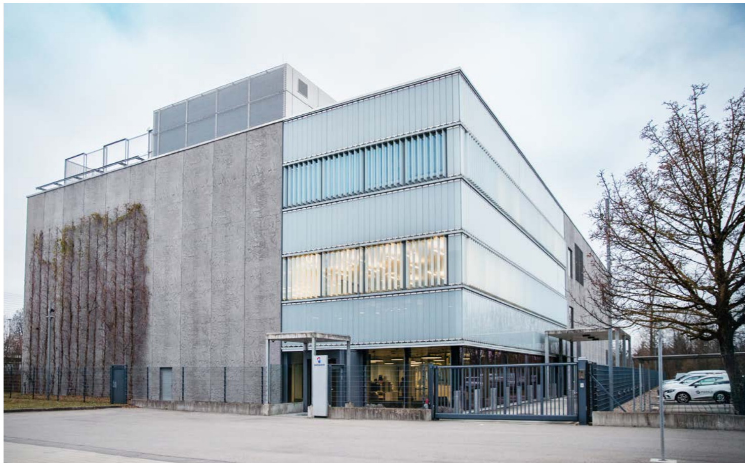
Das Rechenzentrum Wankdorf setzt neue Massstäbe bezüglich Leistung, Sicherheit, Verfügbarkeit und Energie-Effizienz. Dank einem neu entwickelten Stellkonzept bietet es Platz für über 5'000 Server.
