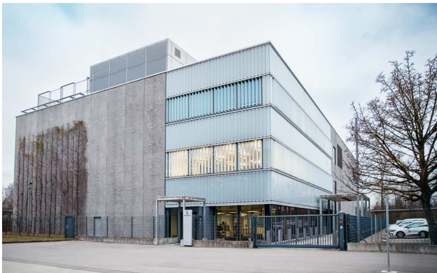
Il Data Center di Wankdorf stabilisce nuovi standard in termini di prestazioni, sicurezza, disponibilità ed efficienza energetica. Grazie ad un'organizzazione innovativa dello spazio è in grado di ospitare oltre 5000 server.
